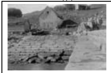
Båtopptrekket med gangspill. Bilde fra 1929 hvor skade på båtopptrekk ble besikket.
