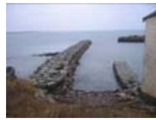
Østre molo med båtopptrekk/stø.
