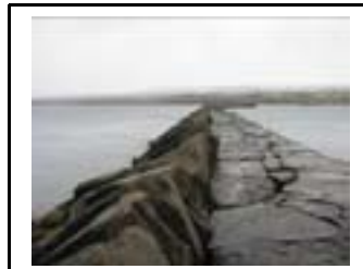
Brystningen på søre molo er også solide blokkstein.
