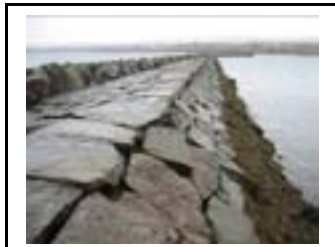
Molo i sør. Meget solid murverk, med steinblokker på opptil 3 meters lengde!
