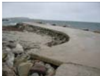
Hele dekningsmuren/moloarmen er dekket av betong.
