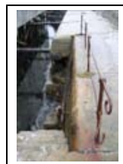
Pent rekkverk som dessverre ikke har blitt vedlikeholdt.
