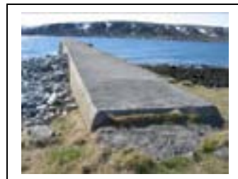
Det er betongdekke på hele moloen.
