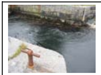
Fortøyningsanordning i innløpet.
