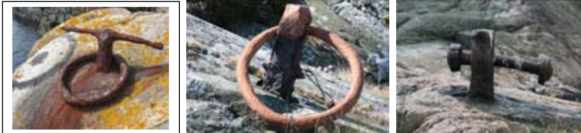
Eksempler på ulike fortøyningsringer/påler
