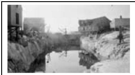
Utdyping av Yttervågen til – 2 meter 1925 – mot sør.
