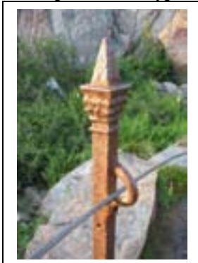
Rekkverkstolpe av støpejern.
