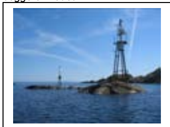
Den nye tid - lykter med indirekte belysning i innløpet til Sørvågen.
