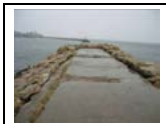
Dekke av betong, og nye stein til bølgebryting på nordre molo. Søndre molo i bakgrunnen, med lykt med fyrlistenummer 973500 og navn Vadsø havn, fra 1906.
