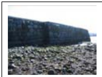
Moloens ytterste del er bygd noe bredere enn innerste del. Av 78 meter molo er 65 meter tørr på fjære sjø.
