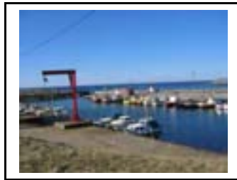
Havn, allmenningskai med kran og innløp.
