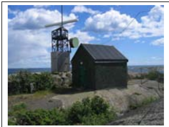
Tjønneberget radarstasjon, Tjøme kommune
