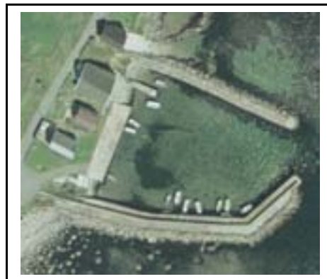
Ortofoto av Østhasselstrand molo og redningsstasjon.
