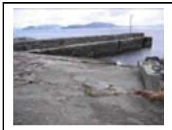
Eltvik molo med båtopptrekket. Boltene man kan se ble brukt til feste for stokker som båtene ble dratt opp på.
