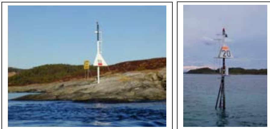
Lanterner med indirekte belysning, HIB (hurtigbåtled-merking)
