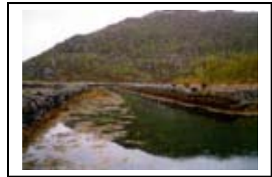
Søndre kanalmur er tørrmurt, mens i nord er det en kantet rausmur.
