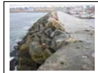
Skuldermolo som er lagt til beskyttelse av østre molo. Steinen kommer fra steinbruddet i Skallelv.
