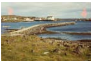
Langskjærmoloen i 1975 etter at moloen har fått betongdekke.
