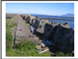
Tangskjærmoloen med brystning og plan molokrone.
