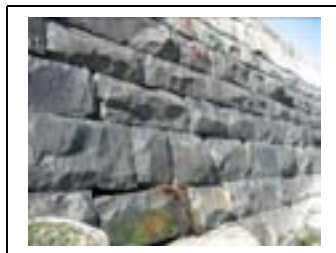
Detaljer av den fint murte moloen med steinblokker som er pent tilpasset.
