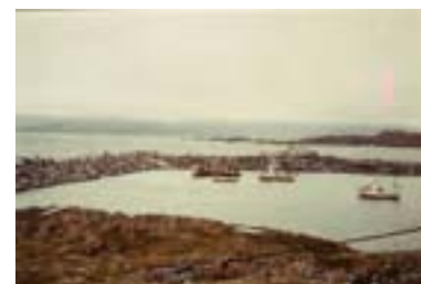
Molohuken på Ringskjærmoloen sett fra landsiden. Kaifyllingen er under utkjøring.
