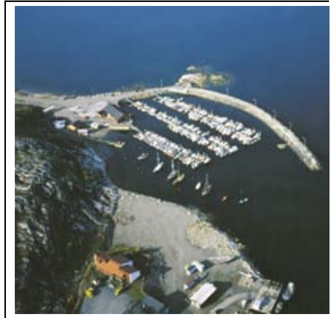
EKSEMPEL PÅ HAVN DER BUNNKJETTINGSFORTØYNING ER SKIFTET UT MED FLYTEBRYGGER. (SKAJALUFT, ALTA KOMMUNE, FINNMARK FYLKE)
