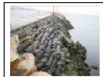
Molo i nord, med pent opplagte blokkstein.
