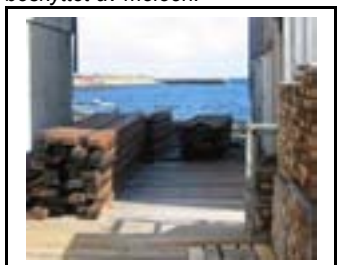
Moloen sett fra et kaianlegg under restaurering i Hamningberg.
