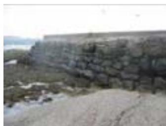
Steinblokker er lagt lagvis.
