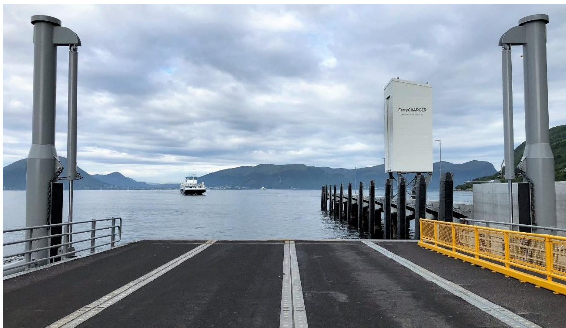
Høyspent ladeanlegg på Sulesund ferjekai. Foto: Einar Bjørshol
