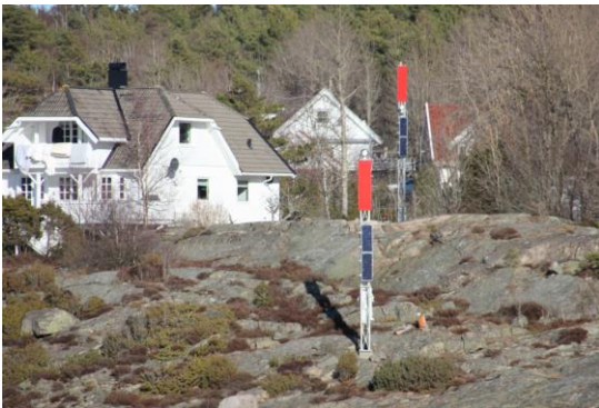
Overett med røde rektangulære refleksplater. Observert fra fartøy litt til styrbord for senterlinjen
