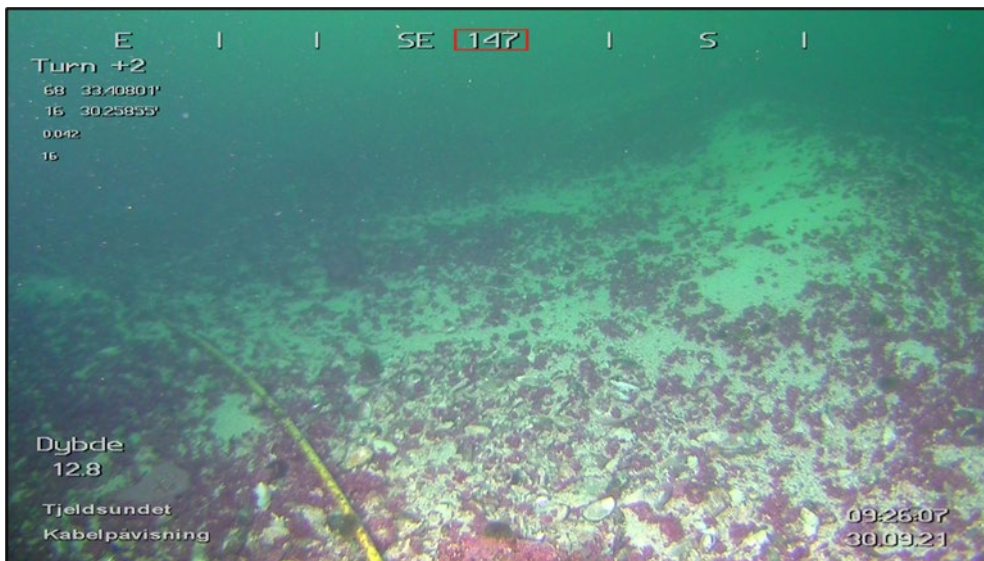
Figur 21 Sjøkabel ved Steinstiggrunnen. (ROV-foto Multiconsult)
