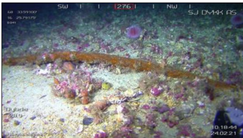
Figur 20 Delvis nedgrav kabel/rør ved Hårvika. (ROV-foto Multiconsult)
