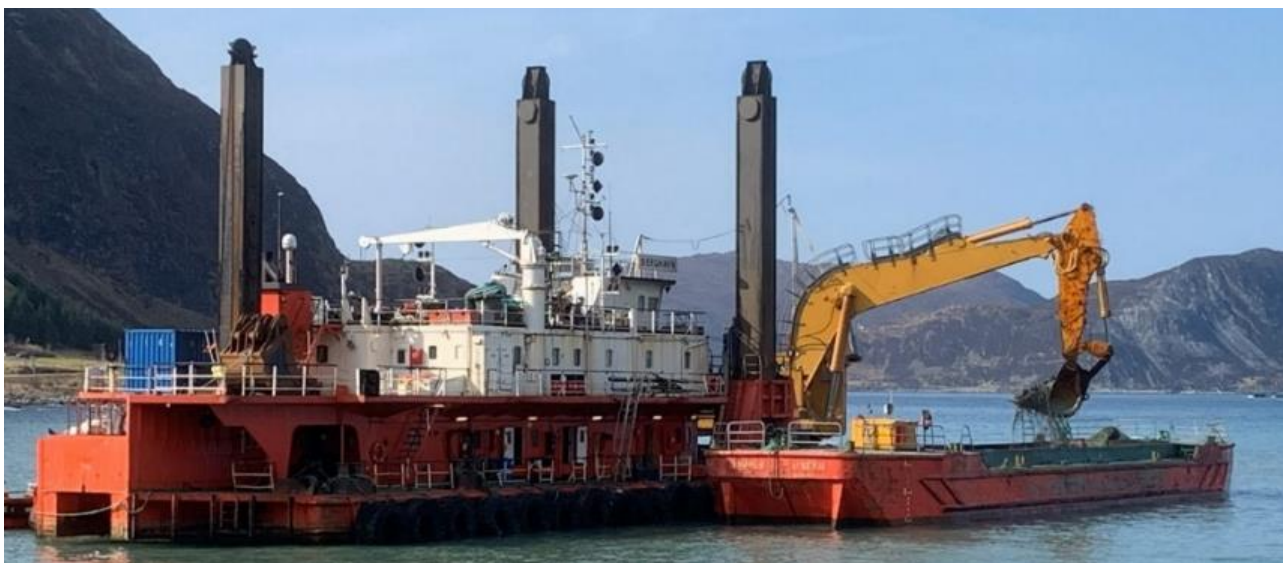
Figur 6 Utdjupeing vil bli utført frå eit mudringsfartøy. Steinmassane som blir sprengt ut blir teke opp og mellomagra på lekter før dei blir frakta til eit regulert deponi på sjøbotn eller til eit område på land.
