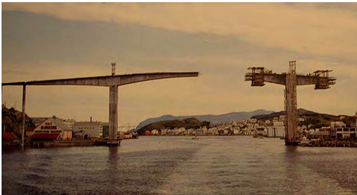
Foto 1-1 Fra byggetida, akse 8 til venstre, akse 9 til høyre
