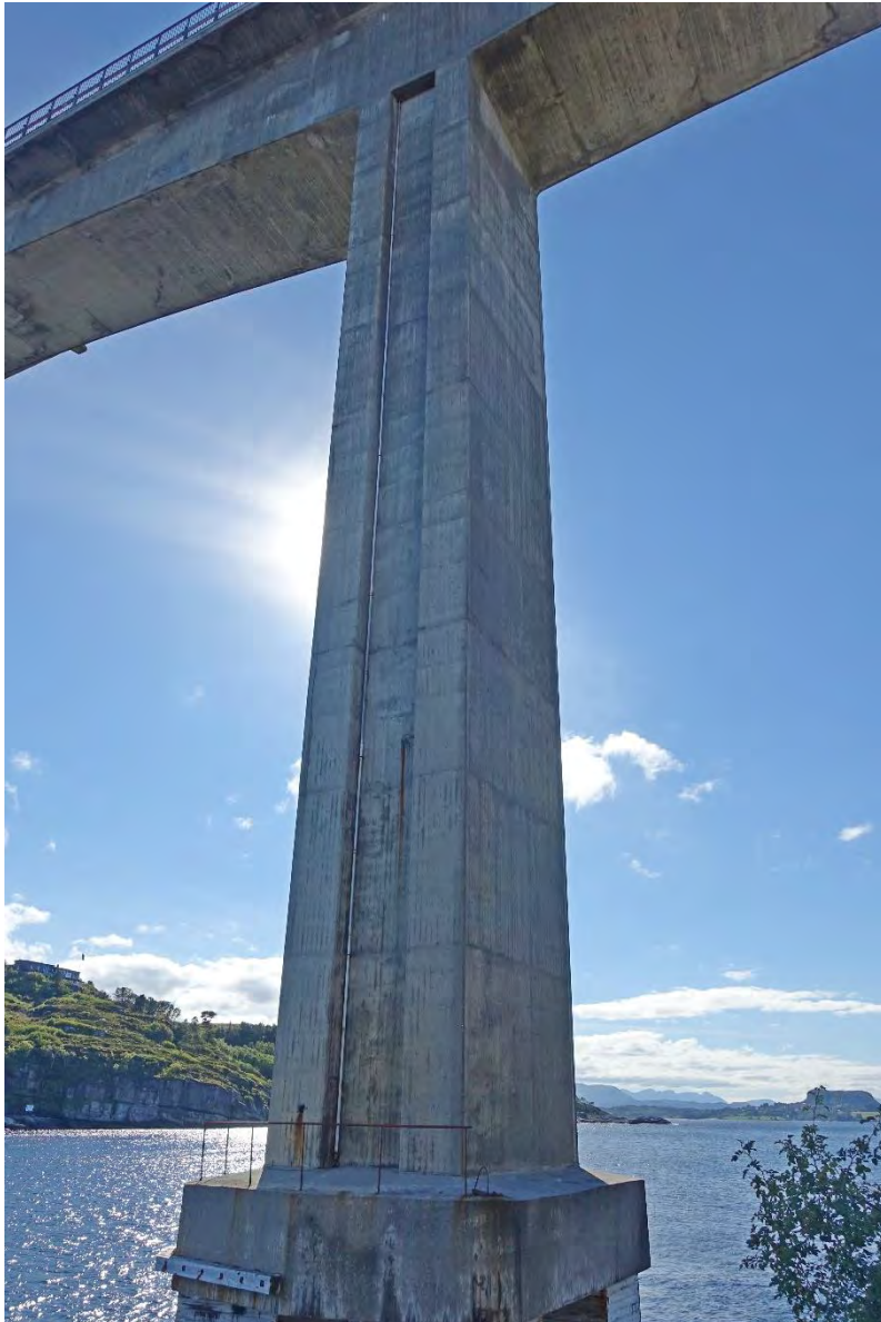
Foto 0-1 Tårn og fundament akse 8
