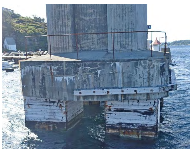
Foto 2-3 Fundament A9 fra øst
