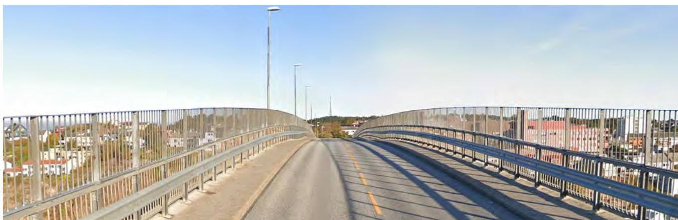
Foto 3-1 Viser overside av brua i midtspennet over seilløpet.
