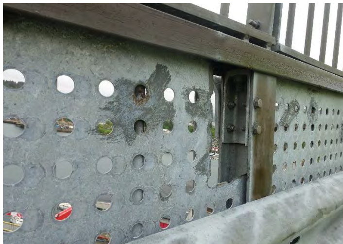
Foto 3-2 og 3-3 av brøytetett perforert plate på nedre del av rekkverket
