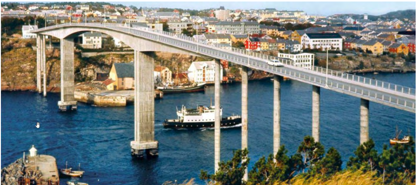
Foto 2-7 Viser brua i 1964, ett år etter åpning.
