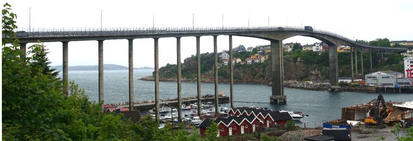
Foto 2-1 Brukryssing sett fra sørøst
