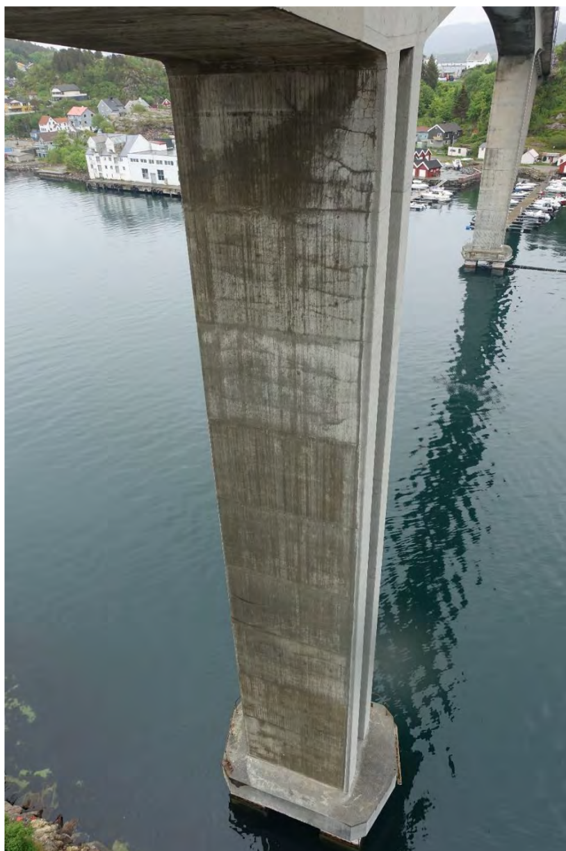
Foto 0-2 Tårn og fundament A8 fra nordvest
