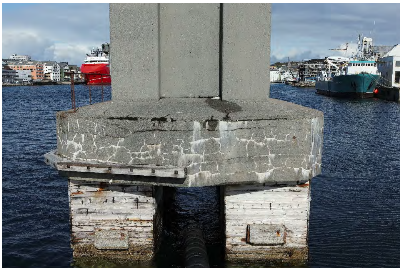
Foto 0-1 Fundament A9 sett mot Kristiansund havn
