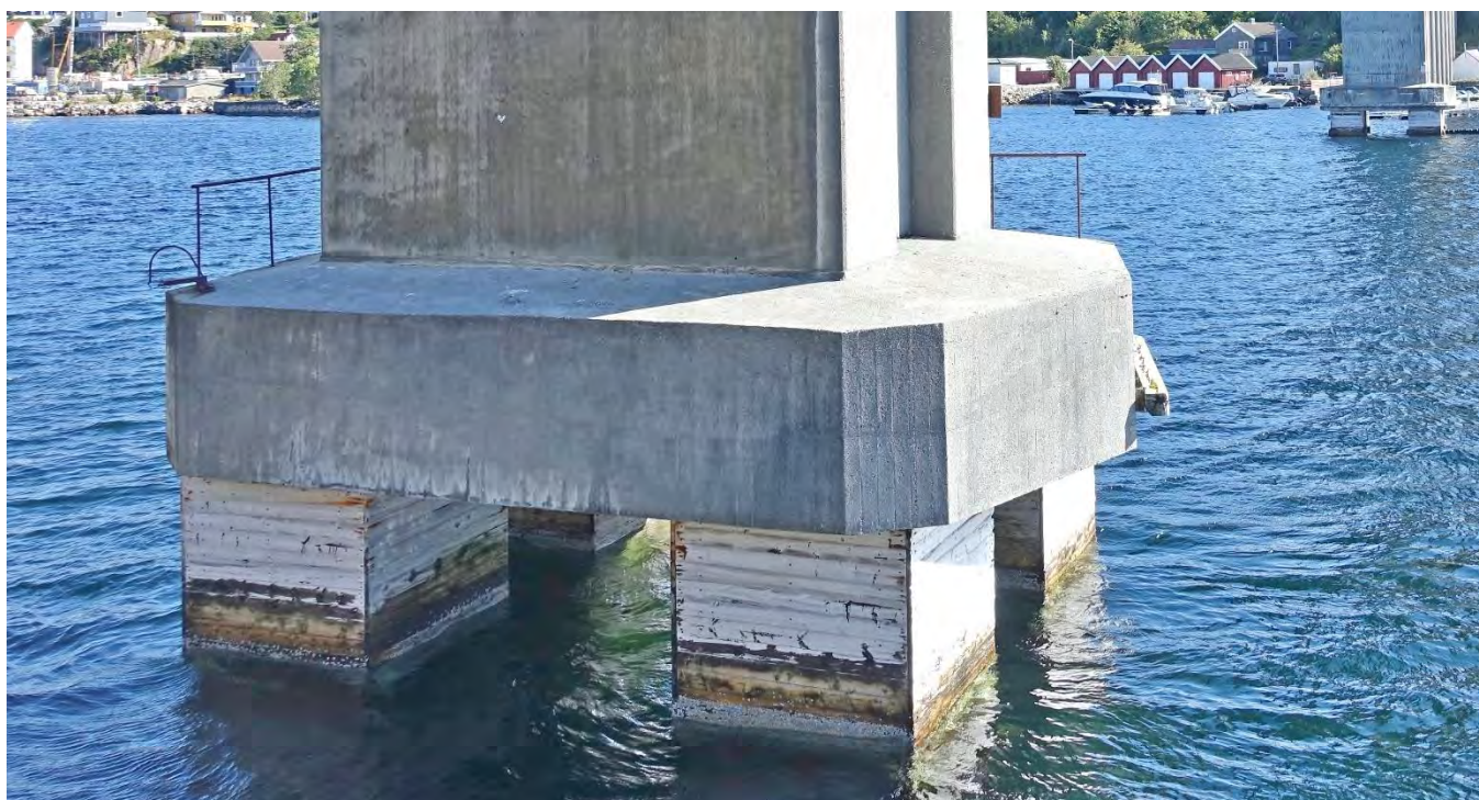
Foto 2-4 Fundament A8 fra nordvest
