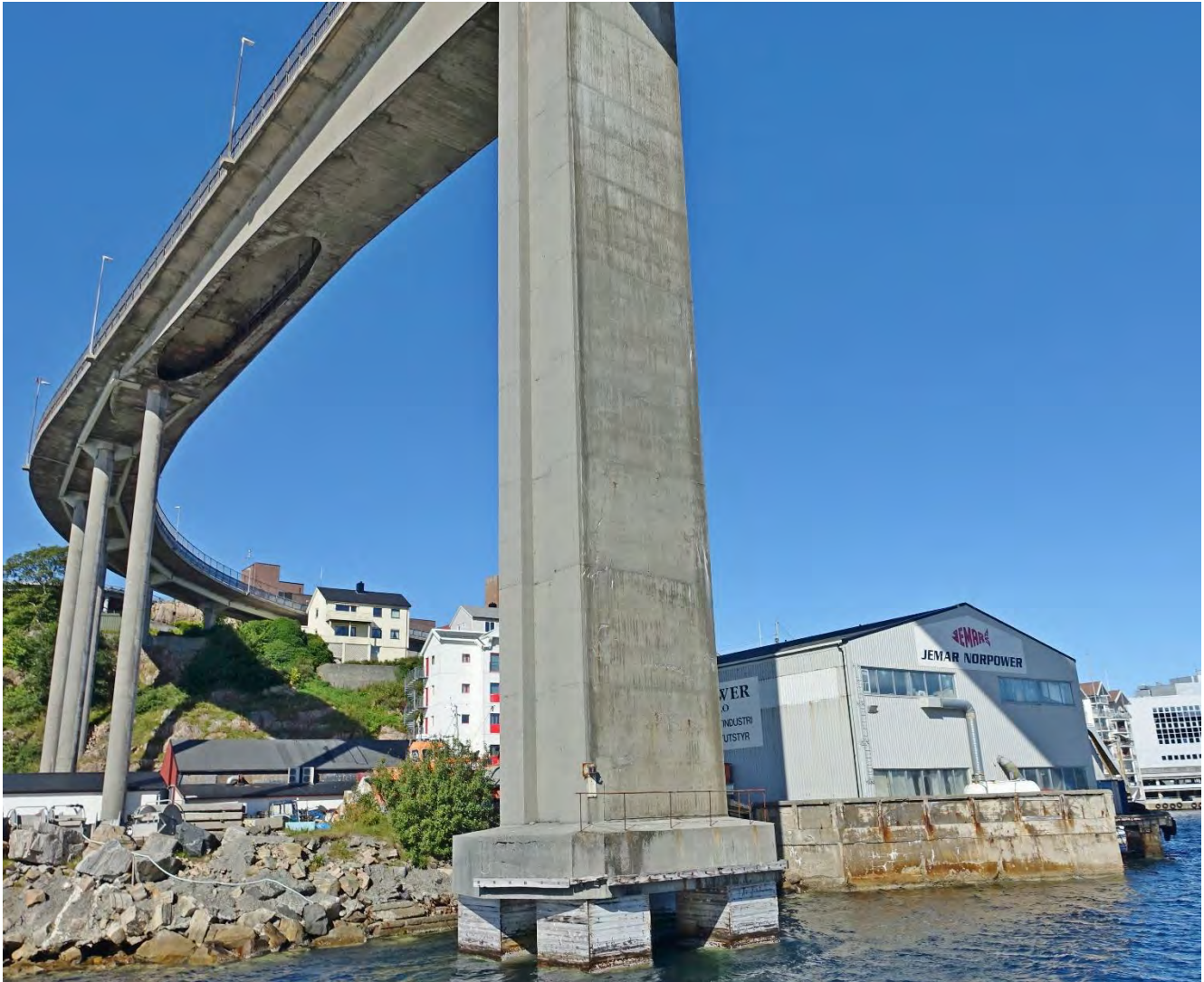
Foto 0-1 Pilar akse 8 fra sørvest
