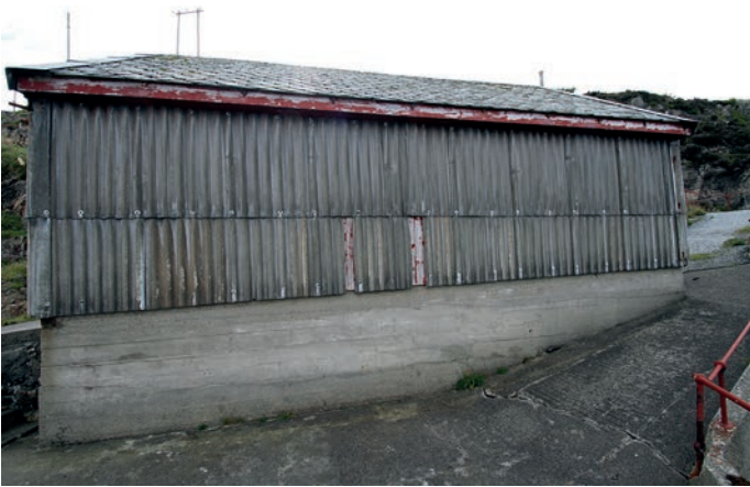
Fasade mot nord, mot sundet.
