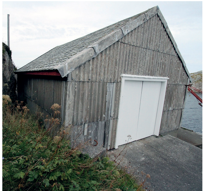
Over: Tak med lappskifer. Under: Eternitt bølgeplater rund baut.
