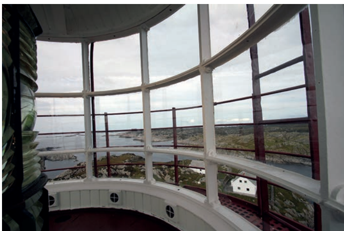
Over: Vinduer i støpejernsrammer i fyrlykt. Under: Galleri av støpte sammenskrudde jernelementer.
