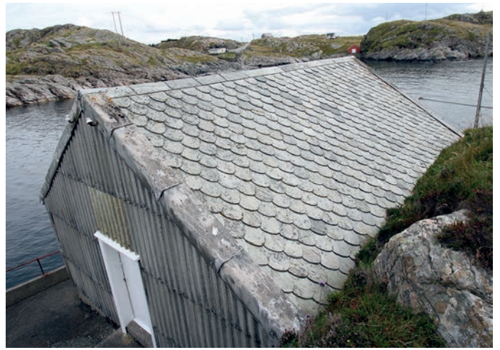
Over: Tak med lappskifer. Under: Eternitt bølgeplater rund baut.
