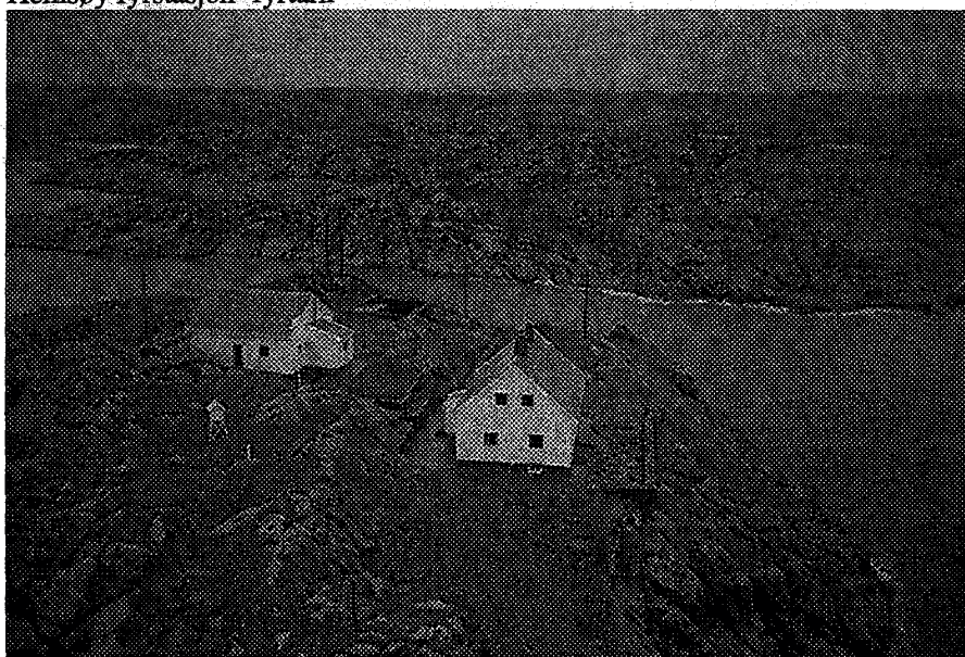
Hellisøy fyrstasjon - fyrvokterbolig og maskinhus
