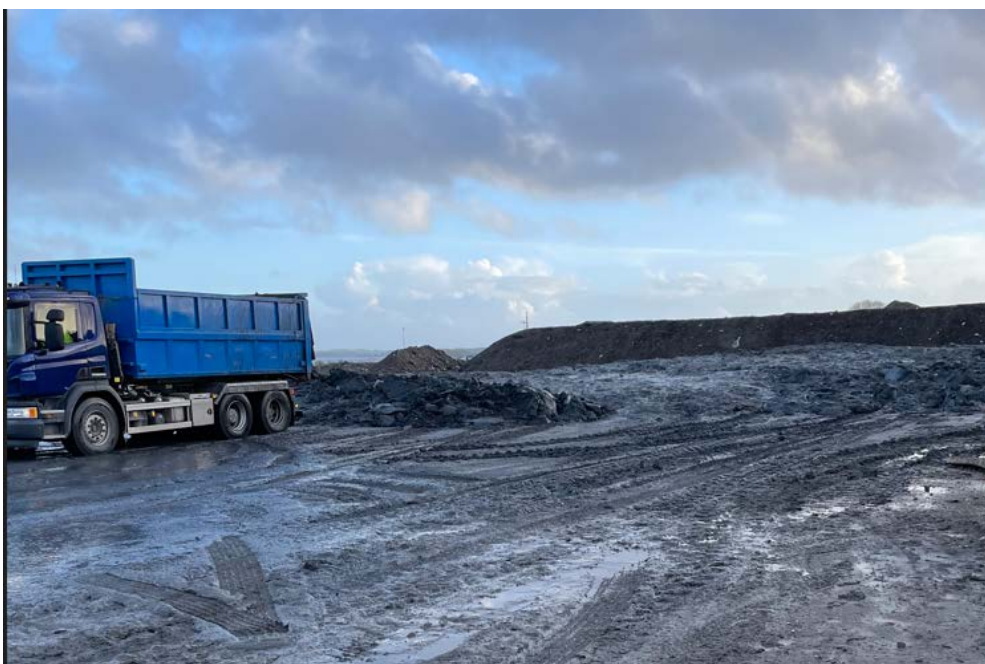
Figur 2-4 Omlasting og utlegging av mudringsmasser ved FREVAR.
