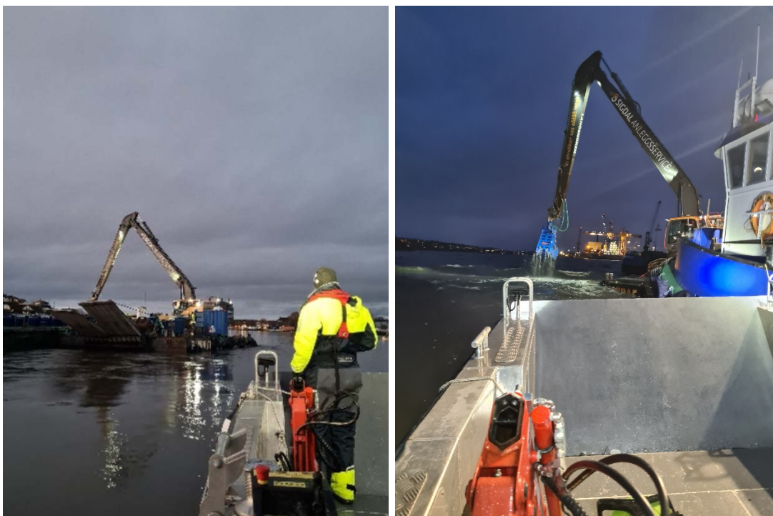
Figur 2-3 Bilder fra prøvemudring som viser bakgraver på mudrepreman og lossing til lekter (til venstre) og måleposisjon like nedstrøms for mudrepreman under mudring med grabb (til venstre).
